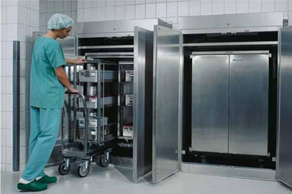
La fase di trasferimento della struttura alla zona sterile può essere effettuato ponendo la cabina di trasporto all'interno di una cabina fissa a doppia entrata. La cabina di trasporto a tenuta potrà circolare nella zona non sterile anche con il suo contenuto sterile.
