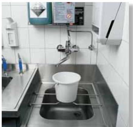
Struttura di scolo con secchiello removibile
